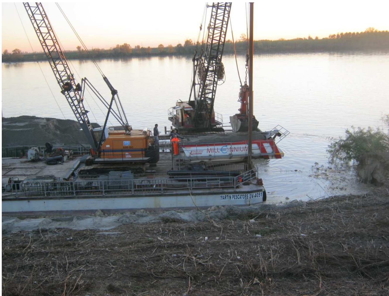
Difesa spondale sx Po – Calto - Pontoni utilizzati per l'annegamento del pietrame e per la formazione e varo dei sacchi di sabbia da 25 mc a formazione della berma sommersa.
